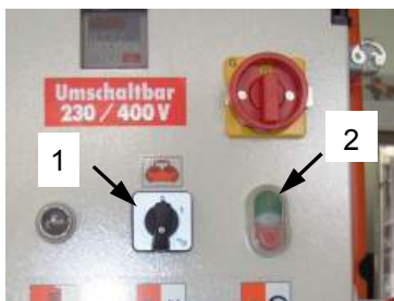
Rys. 46: Włączenie sprężarki powietrznej
