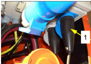
Rys. 44: Włączenie sprężarki powietrznej
