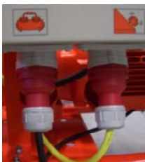
Rys. 20: Podłączenie wibratora i sprężarki powietrznej
