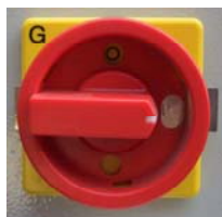
Rys. 27: Urządzenie gotowe do pracy
